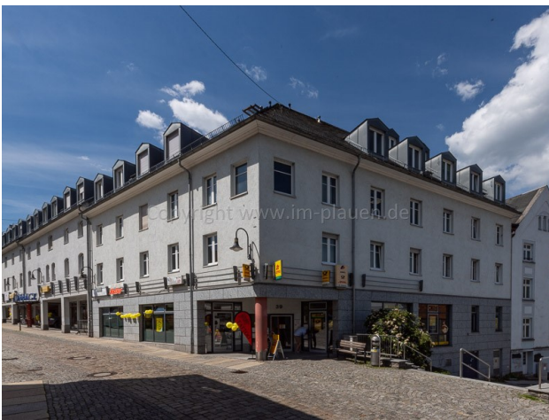
Wohn- u. Geschäftshaus Nicolaipassage Auerbach
