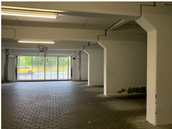
Tiefgarage mit Ausfahrt
