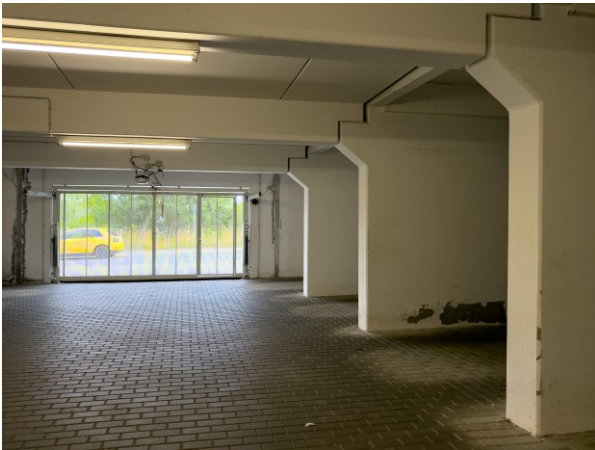
Tiefgarage mit Ausfahrt
